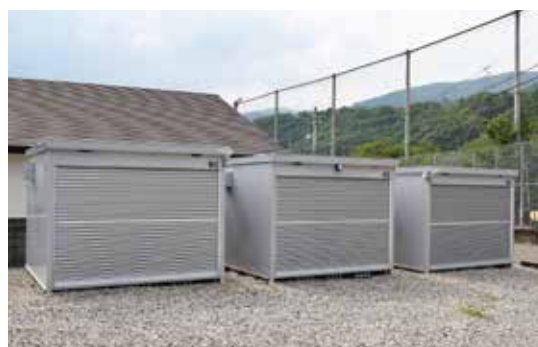
防災倉庫(美馬市合同会館北側駐車場に設置)
